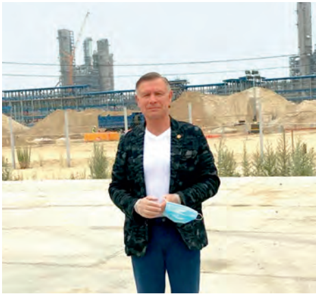
Активная фаза строительства Амурского газоперерабатывающего завода
