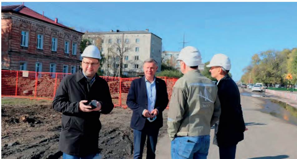
Нулевой цикл строительства автодорожного моста через реку Зея в городе Благовещенске
